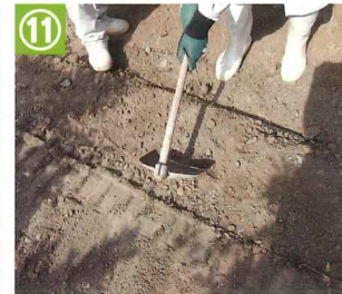
⑪ ジョレンで掘削土の一部を畝側に入れる。
