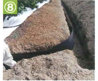
⑧ S.シート+の埋設。 ※シートの継ぎ足しは50cm程度重ねる。
