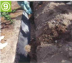
⑨ 畝側にS.シート+を当て、地表面から5cm出して土を一部戻す。
