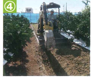
④ 白線に沿ってバックホーで掘削。
