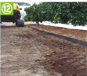
⑫ キャタピラーで転圧。 ※S.シート+を踏まないように注意。
