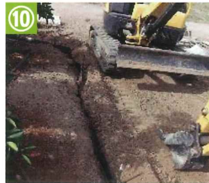
⑩ 掘削土を溝に戻す。
